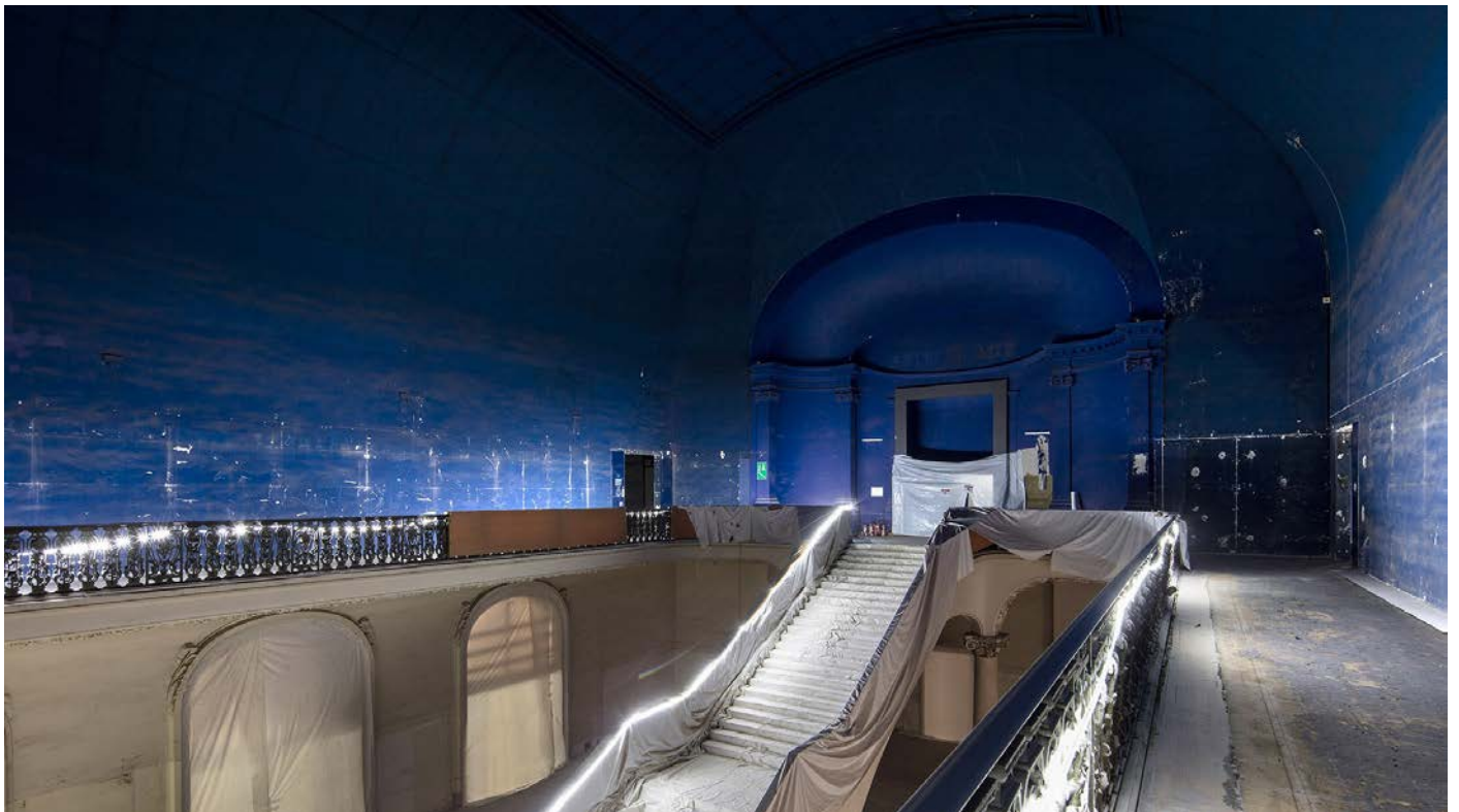
Le chantier du Grand Palais, Paris 2021 © Patrick Tourneboeuf pour la Rmn-Grand Palais / Tendance floue
